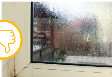
VENTANA CON CONDENSACIÓN POR FALTA DE AISLAMIENTO
