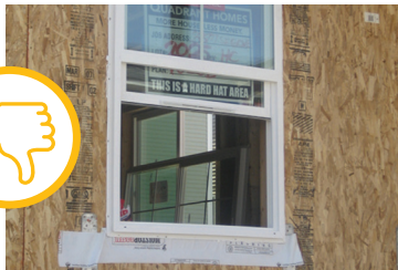
VENTANA CON TAPAJUNTA INSTALADA INAPROPIADAMENTE
