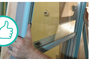
ENCAJE APROPIADO DE UNA VENTANA. ESTABLE Y SELLADO
